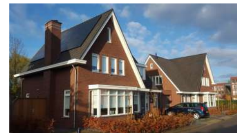
kleur metselwerk en dakpannen, samengestelde kap
