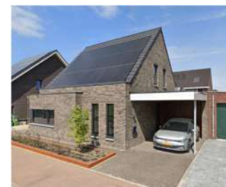
kleur metselwerk en dakpannen, kap richting
