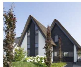
keimwerk gevel, rieten kap, accenten hout
